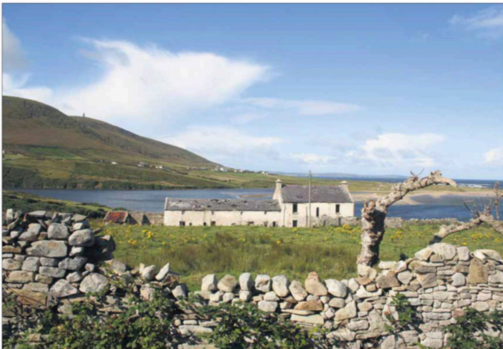
COUNTY MAYO: I forgrunnen landsbyen Rosspport. Bak huset ligger Sruwadd acon-bukta. Shell skal grave en fem kilometer lang tunnel til gassrørledningen under bukta.
